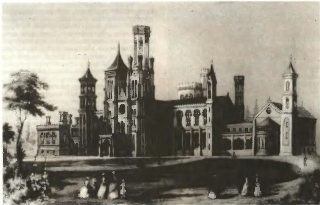
Первоначальный вид здания Смитсоновского института в Вашингтоне. С литографии середины XIX в.
