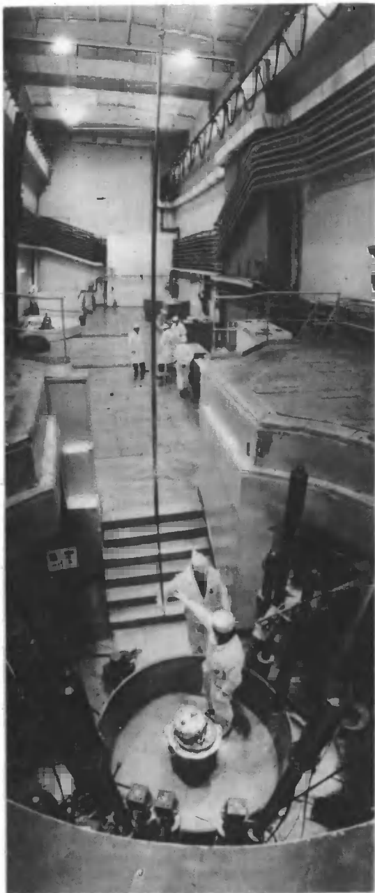
Импульсный реактор на быстрых нейтронах — ИБР-2, физический пуск которого осуществлен в Объединенном институте ядерных исследований. По мощности он во много раз превзойдет все действующие в мире установки подобного типа. Этот уникальный инструмент открывает широкие возможности для исследований перед физиками, биологами, медиками.
